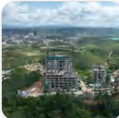
Pembangunan Rusun ASN Ibu Kota Negara (IKN) Nusantara IKN, Kalimantan Timur Construction of ASN Flats, Nusantara National Capital IKN, East Kalimantan
