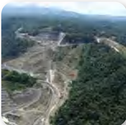
Bendungan Bener, Purworejo Paket II Purworejo, Jawa Tengah Bener Dam, Purworejo Package II Purworejo, Central Java
